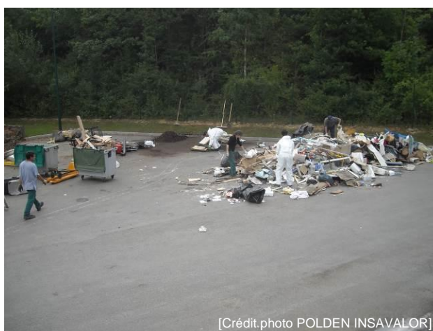
Tri d'une benne tout-venant sur aire bétonnée
